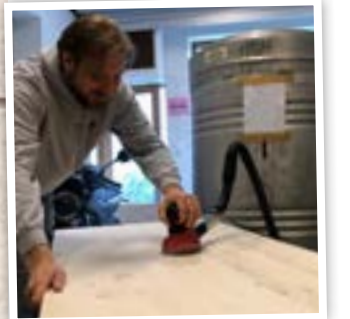
SLIPAR PÅ DETALJERNA. Öltankarna i bakgrunden ska flyttas och ge plats för stolar och bord.
